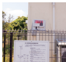
環境放射線観測局表示装置（七尾市西岸局）
