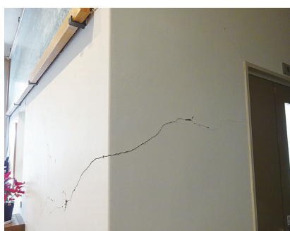
▲壁面の亀裂
