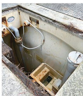
▲浄化槽亀裂
