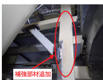
ケーブルトレイサポート補強例
