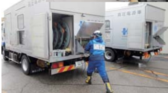
発電所本部(増設緊急時対策所)の運営訓練① 高圧電源車からの給電訓練②
