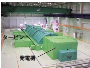
▲タービン建屋内部の様子
