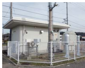
環境放射線観測局 (直海局：志賀町(地図下線)) 空間放射線や風向、風速などを測定しています。
