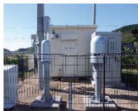
環境放射線観測局 (門前局：輪島市(地図下線)) 空間放射線や風向、風速などを測定しています。
